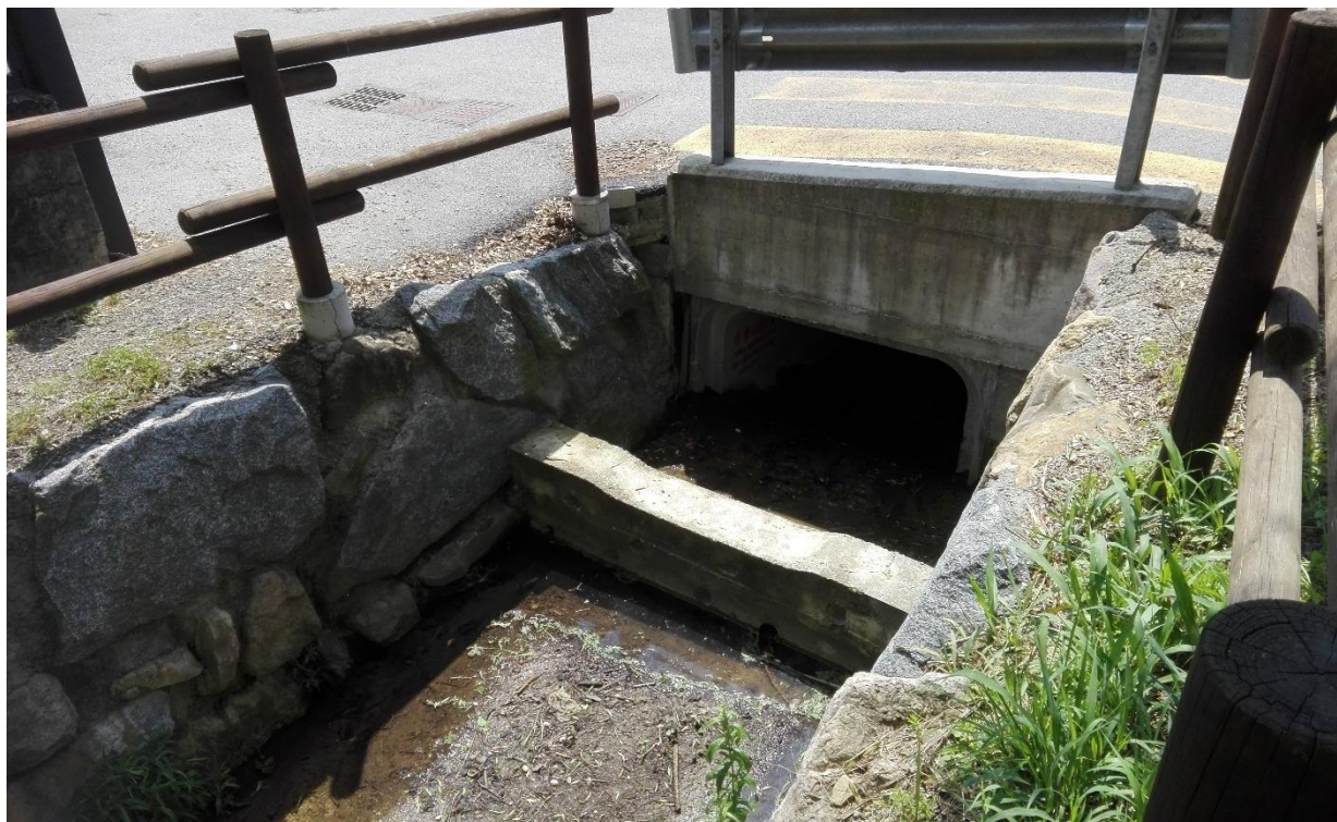
Figura 7: Intervento 3.2 - Rio Foppina, attraversamento di Via Ronchi mediante scatolare in cls di dimensioni 200x125 cm e realizzazione di una trappola per detriti a monte mediante briglia in cls
