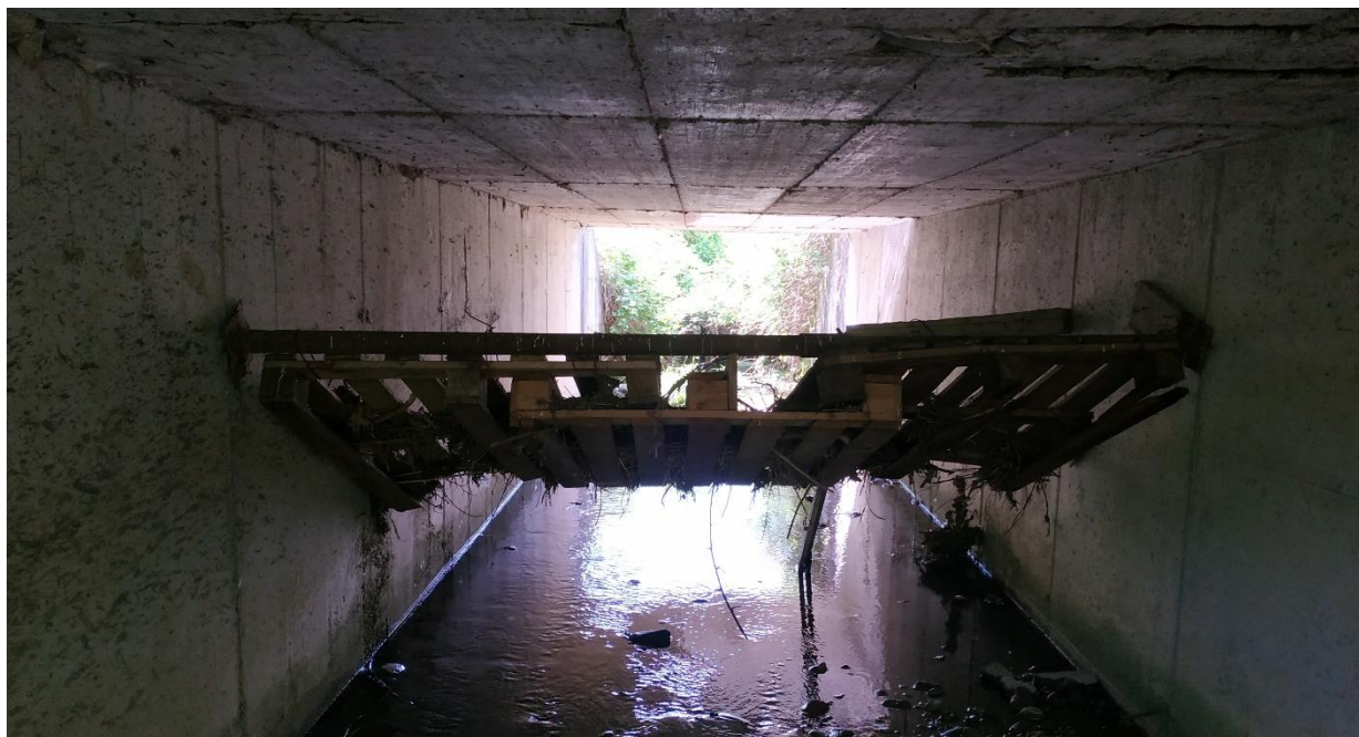
Figura 30: occlusione dell'attraversamento del Rio Prà dell'Ora nei pressi di Via delle Industrie
