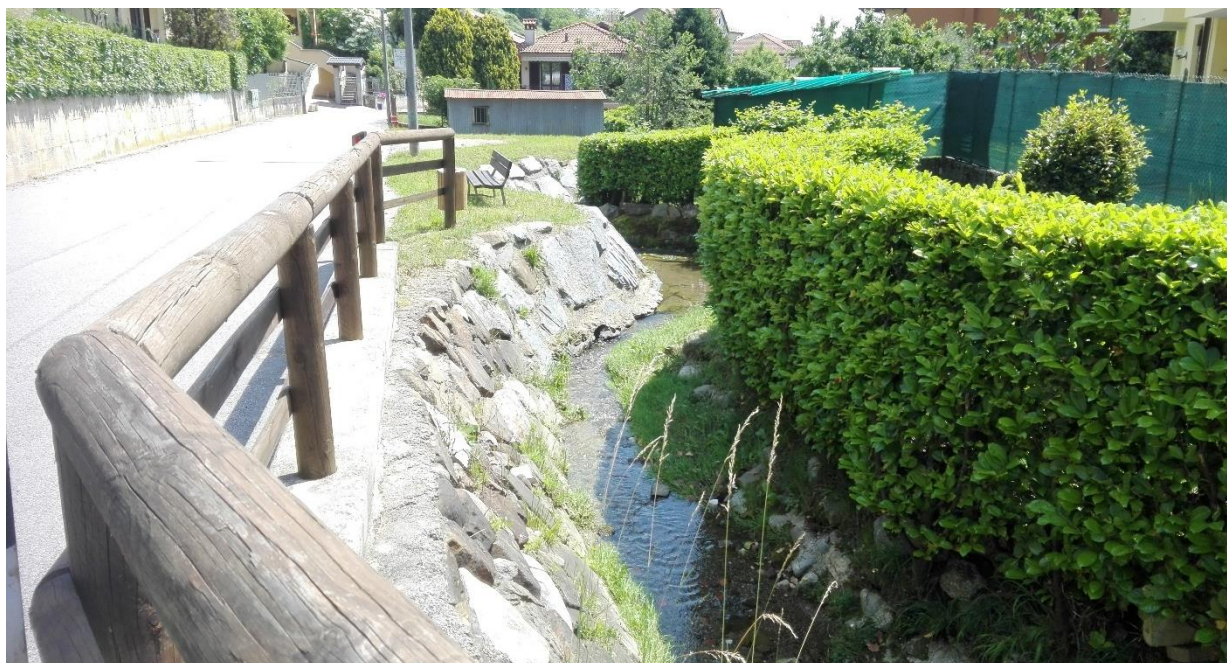
Figura 6: Intervento 2.2 – Rio Prà dell’Ora, risezionamento dell’alveo inciso e protezione spondale mediante scogliera in massi ciclopici
