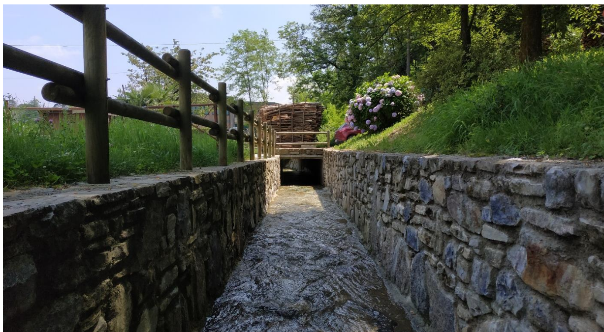
Figura 8: Intervento 3.4 - Rio Prà dell'Ora, risezionamento dell'alveo inciso in località Ceppera e sostituzione del manufatto di attraversamento nei pressi di Via Cenisio con uno scatolare di dimensioni 200x125 cm
